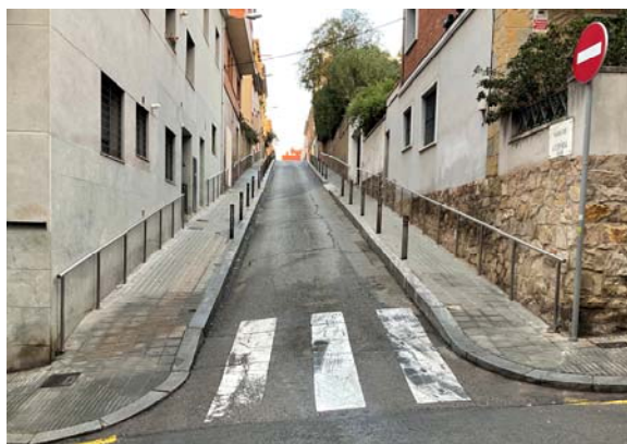
Col·locació i reparació de baranes
