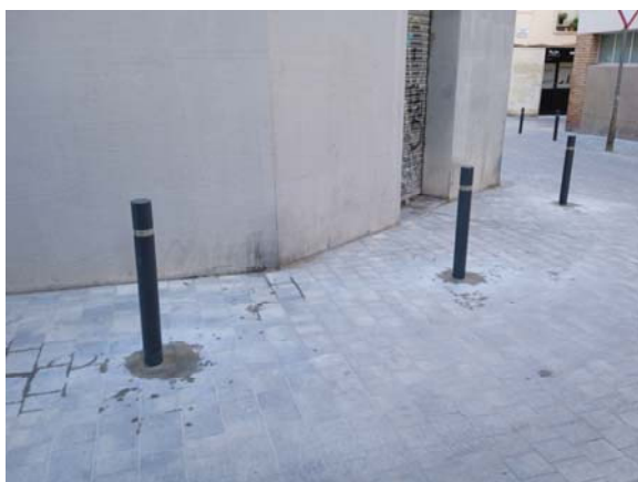
Col·locació de pilones
